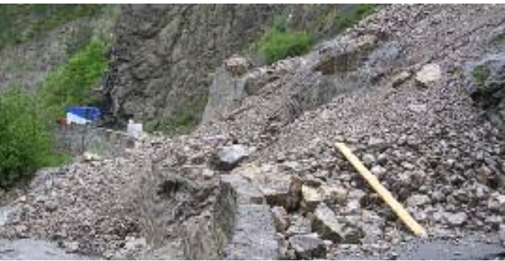
La RD 900 A au passage de la clive de Barles le 3 juin.
